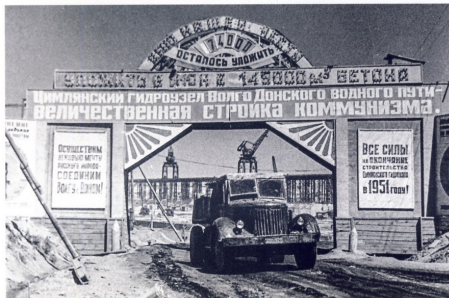
Самосвал MAZ-205 на строительстве канала Волго-Дон
